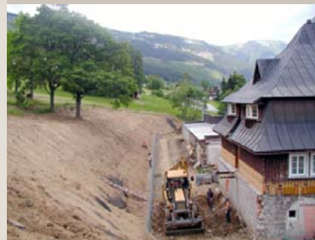
Protierózna ochrana sanovaného svahu po zosuve ve Spindlerovom Mlyne
