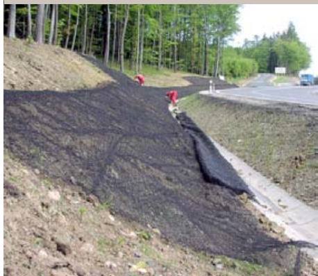
Inštalácia protieróznej georochože na svahy cestného zárezu
