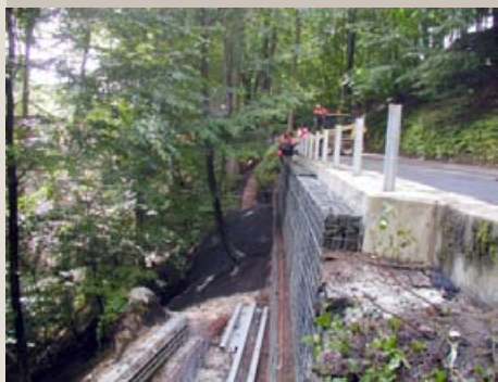
Protierózna ochrana sanovaného svahu po zosuve na ceste III/2823 Hrubá Skála
