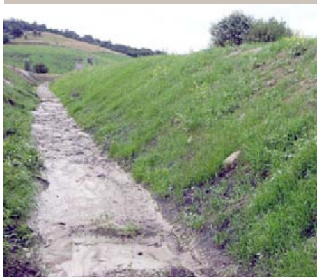
Protierózna ochrana svahu odvodňovacieho kanála
