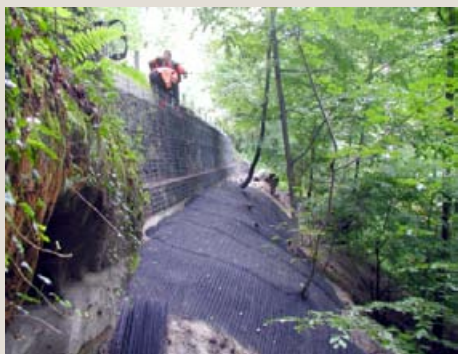
Protierózna ochrana sanovaného svahu po zosuve na ceste III/2823 Hrubá Skála
