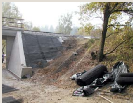
Použitie protieróznej georochože Trinter na svahy mostného krídla pri rekonštrukcii železničného mosta v Hesove
