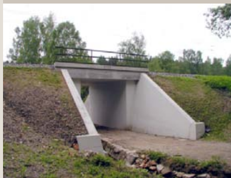
Použitie protieróznej georochože Trinter na svahy mostného krídla pri rekonštrukcii železničného mosta v Hesove
