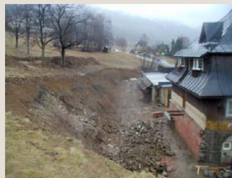
Protierózna ochrana sanovaného svahu po zosuve ve Spindlerovom Mlyne
