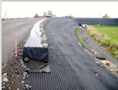
Protierózna ochrana svahov násypu cesty II/247 v Litoměřiciach
