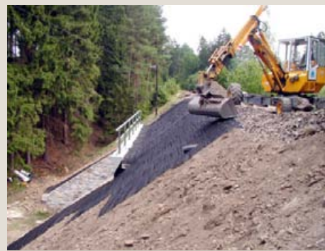
Použitie protieróznej georochože Trinter na svahy mostného krídla pri rekonštrukcii železničného mosta v Urbanči
