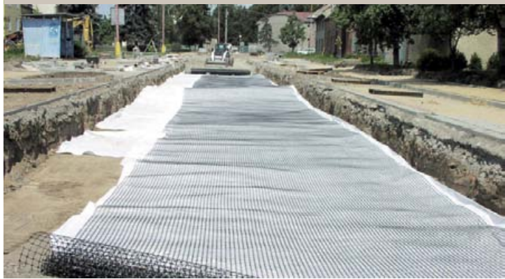
Inštalácia separačnej netkanej geotextílie pod stabilizačnú geomrežu
