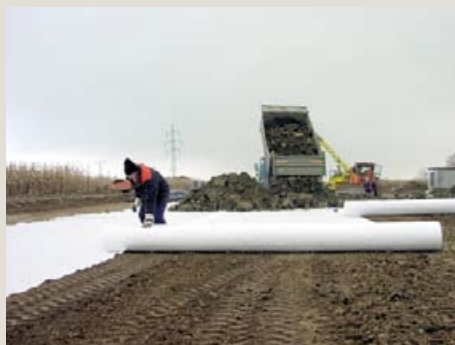
Použitie netkanej geotextílie pre separáciu materiálov na obchvate Lipník nad Bečvou
