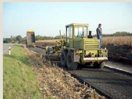
Sepáracia materiálov pri výstavbe poľnej komunikácie v Žatčanoch
