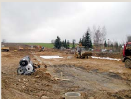
Použitie netkanej geotextílie pre obalenie drenáží pod komunikáciou v Jihlave
