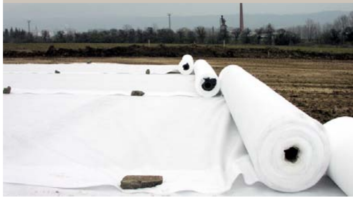
Inštalácia netkanej geotextílie ako separačnej vrstvy pod komunikáciu
