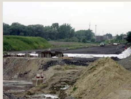
Využitie netkanej geotextílie pre separáciu materiálov pod železničným násypom neďaleko Karvinej
