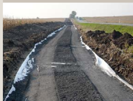
Sepáracia materiálov pri výstavbe poľnej komunikácie v Žatčanoch
