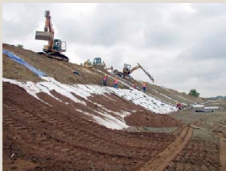
Sepáracia drenážnych rebier na diaľnici D11 v úseku Levín - Chýšť
